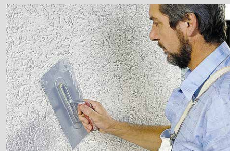
Aussenverputz von Hand aufgebracht, Körnung 1.5 mm
