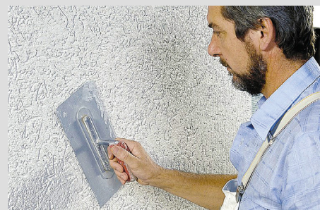
Aussenverputz von Hand aufgebracht, Körnung 1.5 mm
