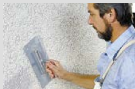
Aussenverputz von Hand aufgebracht, Körnung 1.5 mm
