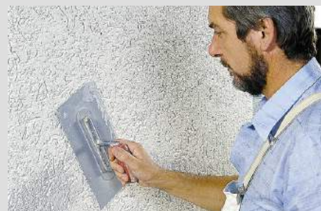
Aussenverputz von Hand aufgebracht, Körnung 1.5 mm
