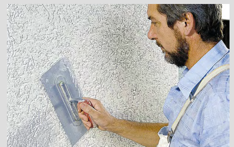
Aussenverputz von Hand aufgebracht, Körnung 1.5 mm
